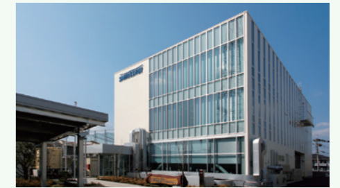
白鷺電気工業株式会社本社ビル
