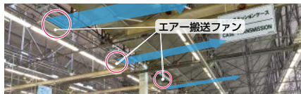
①エアー搬送ファンで有圧換気扇付近へ送風。
