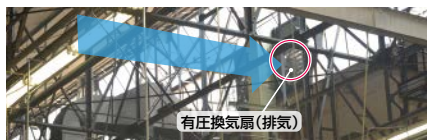
②有圧換気扇で熱気・湿気、空気のおよみを排気。
