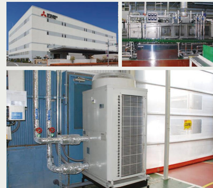
▲洗淨設備と同じ施設内に設置されたホットウォーターヒートポンプ
