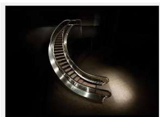
スパイラルエスカレーター外観:曲線となっています。
