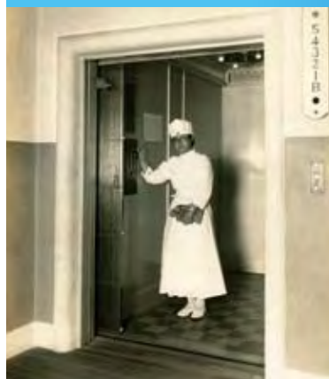
■大阪赤十字病院に納入されたエレベーター。(1933年)
