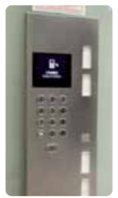
04 ゲストカードの人は、ここで行き先階のボタンを押します。
