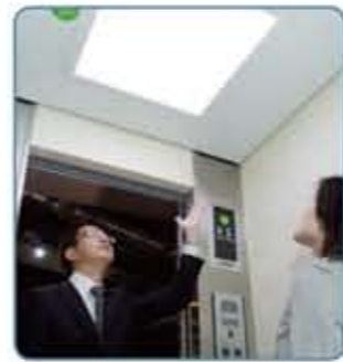
08 LED天井は明るく、フラットなデザインでスッキリしています。
