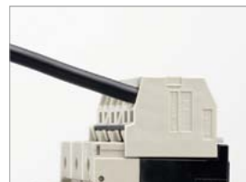
接続完了確認 ※電線を軽く引っ張り、接続ができていることをご確認ください。
