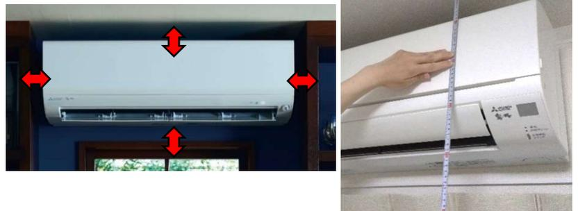
上図のように設置スペースが狭いことがわかっている場合は、室内機のサイズだけでなく、天井や壁、カーテンレールとの隙間も計測している様子を撮影して下さい（上右図）。隙間を考慮せず設置すると、例えば上部の空気の吸い込み口が塞がれてしまうので「冷えない」原因になってしまいます。
