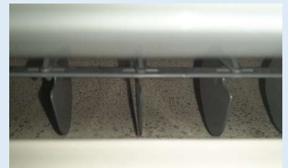
エアコンの吹き出し口にカビが生えた様子
