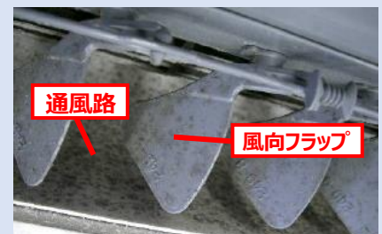
図1：カビが付着した風向フラップ、通風路
