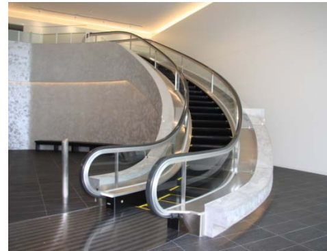
エントランス設置のスパイラルエスカレーター
