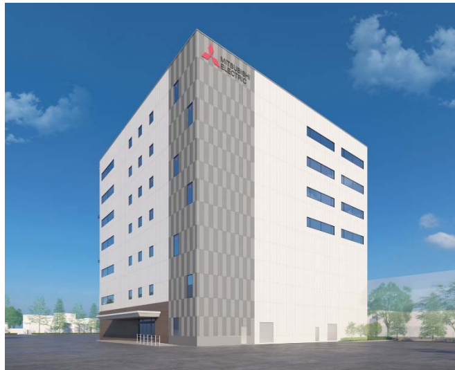
姫路製作所 新実験棟（土山第 15 実験棟）のイメージ
