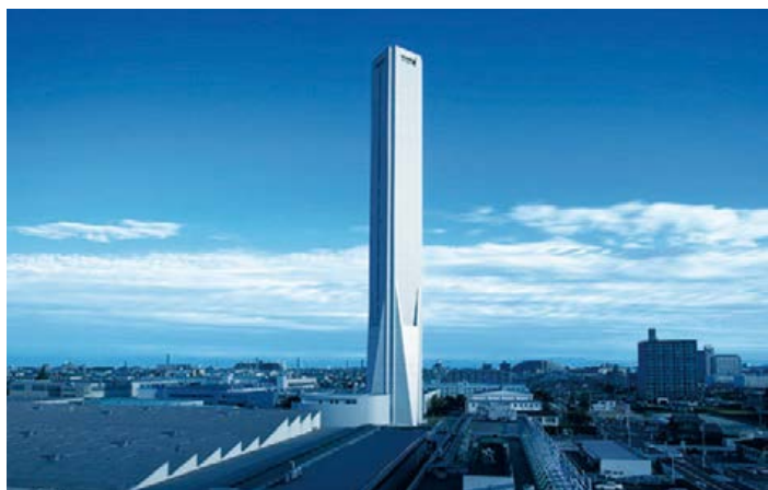
エレベーター試験塔「SOLAÉ（ソラエ）」
