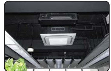
天井の色と製品・配管の色を統一し、給気ダクトはカバーをしてきれいに隠れているため、天井がすっきりしています。
