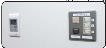
スイッチ1台につき、1系統の制御をしています。
