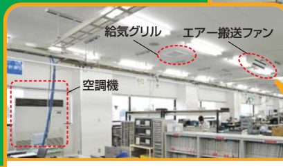
空調機・エア－搬送ファン・給気グリルの位置がわかります。天井高がそれほど高くないので、エア－搬送ファンの取付角度を水平にし、風が人に直接当たらないよう考慮しています。
