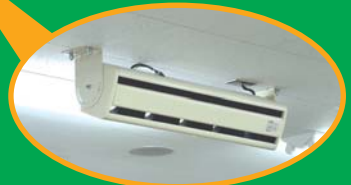
空調機・エア－搬送ファン・給気グリルの位置がわかります。天井高がそれほど高くないので、エア－搬送ファンの取付角度を水平にし、風が人に直接当たらないよう考慮しています。
