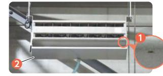
「①排出用抜き孔」から滴下したオイルを「②オイルパン」で受け、ドレン排出口へ流すことでオイルを排出します。
