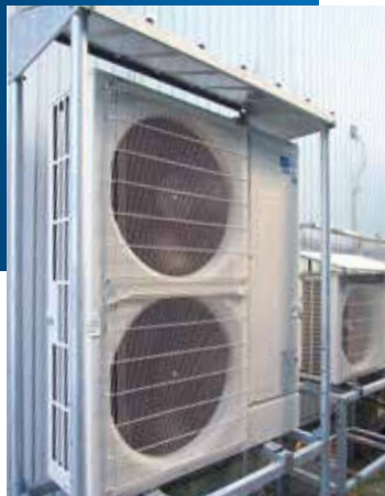
▲室外ユニットカバー、架台設置で積雪対策。
