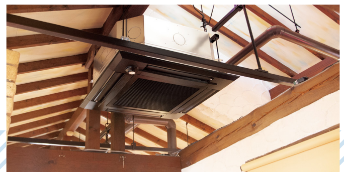
▲ツインのもう一方の設置状況。更新前は客席に空調ムラが生じたが、「ぐるスマ」の風よけ機能によって解消された。
