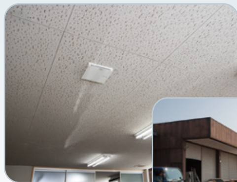
入口側からのショット。奥に応接室と給湯室がある。
