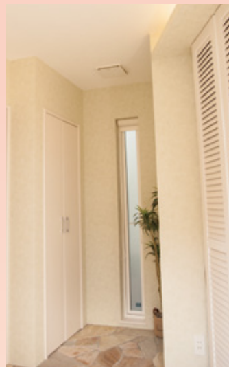
玄関ホールの天井に設置
