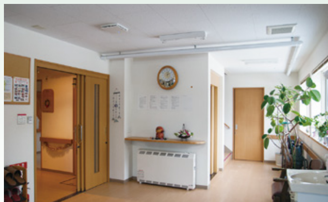
玄関周りの循環ファンの設置場所は施設ごとに少し異なる。「ふれあいほうす」ではエントランスホールに。
