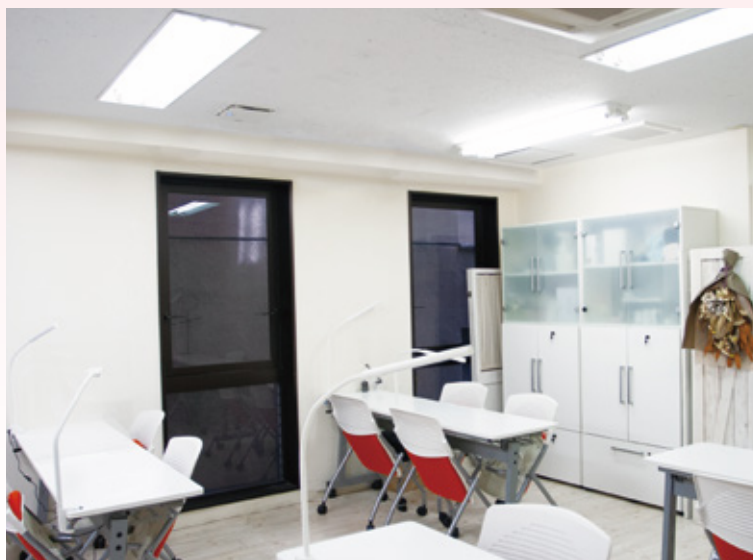
併設されているネイルスクールにも循環ファンが2台採用された。 1台は教室、もう1台は講師控室用。
