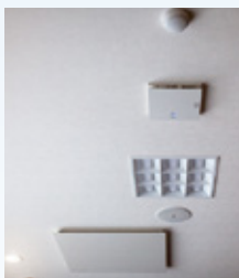
第1会議室には循環ファンとともに天井カセット形ロスナイも採用された。
