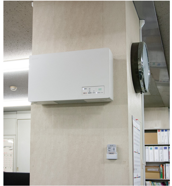
学生総合支援部(上)でも管理本部(下)でもリモコンは柱付け。24時間運転なのでメンテナンス時以外の操作は不要。
