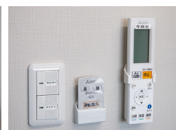
循環ファンのリモコンはホルダーで壁付けに。これは専務室の例（写真中央）。
