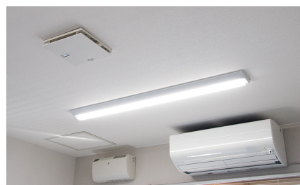
専務室（約11.5㎡）に設置された10畳用。エアコン霧ヶ峰・ロスナイも導入し、検証も兼ねて三菱電機製品で統一している。
