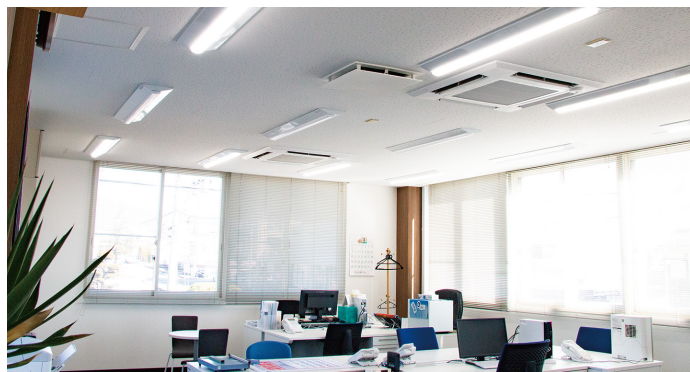
十数名が勤務するオフィスフロア（約63㎡、天井高2.5m）には、30畳用を1台設置。天井埋込形換気扇も導入した。エアコンはムーブアイ付き。
