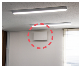
十数名が勤務するオフィスフロア（約63㎡、天井高2.5m）には、30畳用を1台設置。天井埋込形換気扇も導入した。エアコンはムーブアイ付き。
