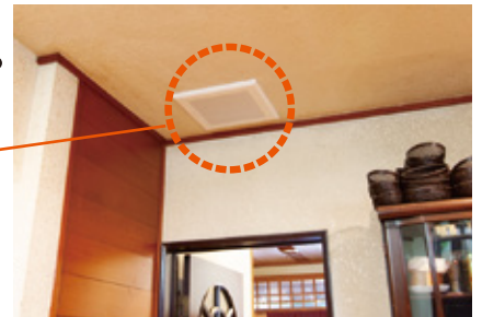
メインルームのCO 2 センサー搭載ダクト用換気扇(VD-20ZAGVX S -C)。こちらもDCブラシレスモーターを搭載している
