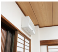
カウンター席のダクト用換気扇。更新後の機種はDCブラシレスモーターを搭載、省エネ性に優れ、配管圧損に左右されず安定した換気風量を確認できる
