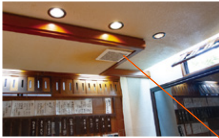
カウンター席のダクト用換気扇。更新後の機種はDCブラシレスモーターを搭載、省エネ性に優れ、配管圧損に左右されず安定した換気風量を確認できる
