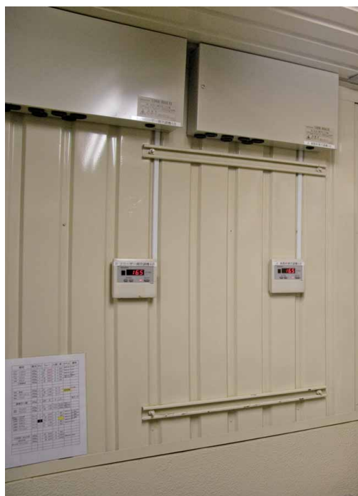
◀コントローラは事務所に設置。壁側と窓側の2系統で制御している。室温は通常17℃、夏季は14～15℃設定
