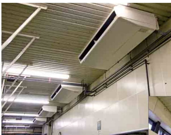
▲▶ スタイリッシュクーラ8台が設置された作業室。窓側は陽射しが当たるため、室温が2～3℃高くなる。そのため、窓側のサーモ位置は少し内側に移動させた
