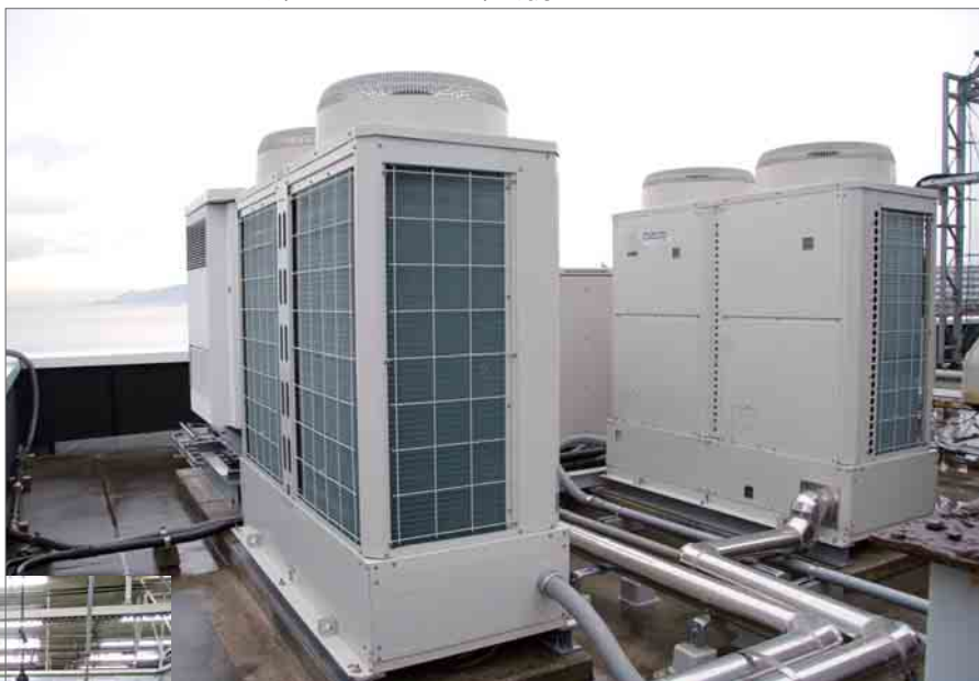
▼ 本社工場の屋上に設置された重耐塩害仕様のR410A一体空冷式インバータコンデンシングユニット(ECOV-EN150MB-BSG)20馬力
