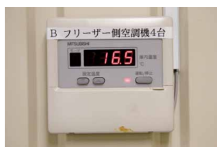
◀コントローラは事務所に設置。壁側と窓側の2系統で制御している。室温は通常17℃、夏季は14～15℃設定
