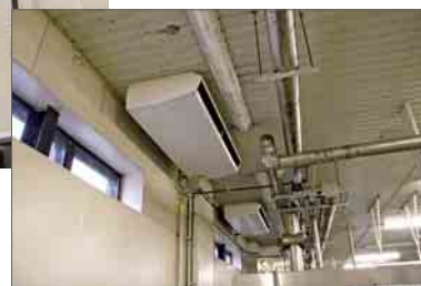
▲▶ スタイリッシュクーラ8台が設置された作業室。窓側は陽射しが当たるため、室温が2～3℃高くなる。そのため、窓側のサーモ位置は少し内側に移動させた
