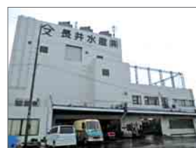
▲ 本社工場(上写真)、第二工場、久里浜工場を保有
