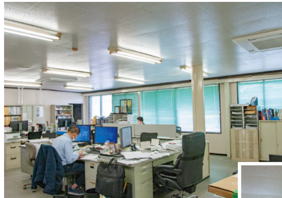
2階の室内。オフィス部分の空調面積は、1階は廊下を含めて約60㎡、2階は約90㎡。 1階はスリムZRの4馬力シングル、2階は8馬力ツインと、更新前と能力は同じ
