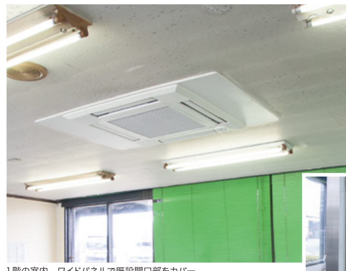
1階の室内。ワイドパネルで既設開口部をカバー
