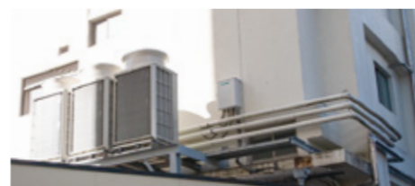
地上から見た室外ユニット。右から1階用、2階用、3階用。既設の配管3本を流用することで大がかりな工事を回避した
