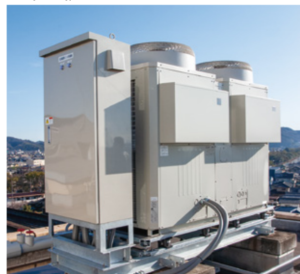
屋上に設置された更新後の熱源機、ホットウォーターヒートポンプ
