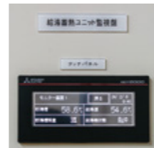
7階の機械室には給湯管 理用監視盤を新設。運転 状況を確認でき、もし不具 合があれば屋上に行く前 に状態を把握できるので 初動が早まる点もメリット
