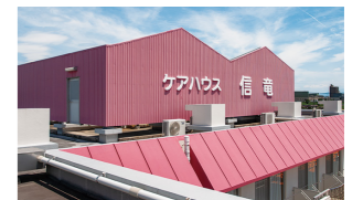
建屋の看板に見える塀の中が室外ユニット置場となっている
