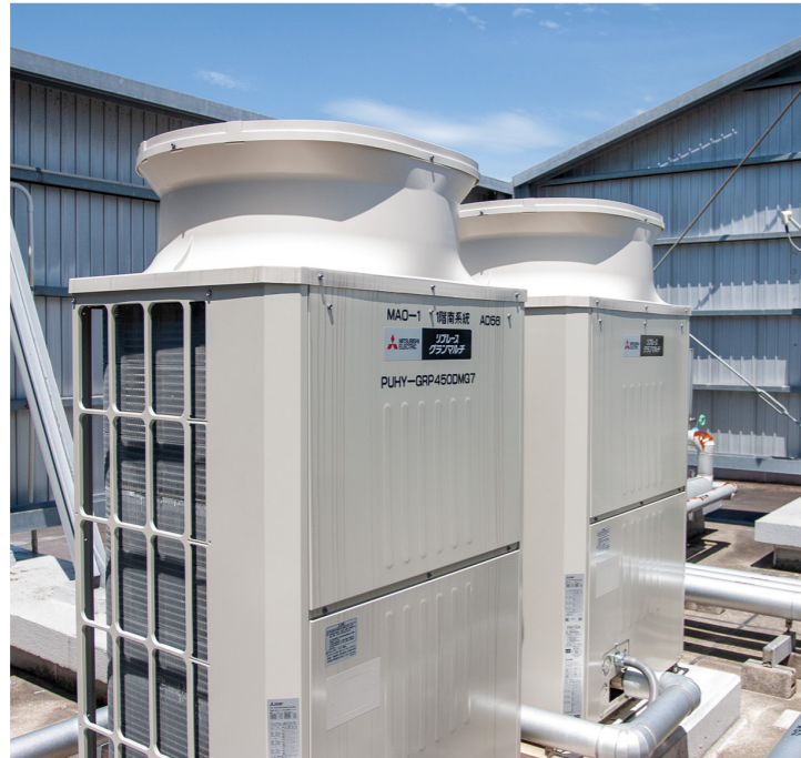
▲ 補助金が採択されたので高効率機種グランマルチを導入
