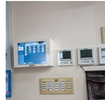
▲ 空調機の集中管理はAE-200Jで、履歴データが取り出しやすく、成果報告も容易
