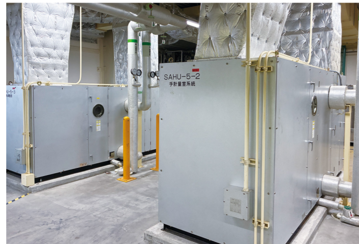
▲ 外調機として使うエアハンドリングユニットに冷温水を供給
