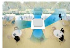
従来の上下ベーンに加え、左右ルーバーユニット(別売)の装着により、気流がいざとどきにくかったエリアにもきちんと風をとどけます。「人感ムーブアイ」との連動で温度ムラをよりすばやく解消し、風あて/風よけをより細かく制御できます。
