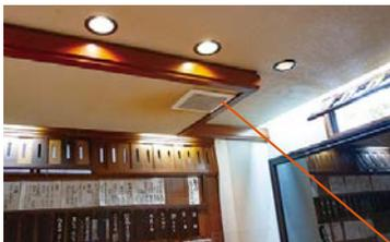
カウンター席のダクト用換気扇。更新後の機種はDCブラシレスモーターを搭載、省エネ性に優れ、配管圧損に左右されず安定した換気風量を確保できる
