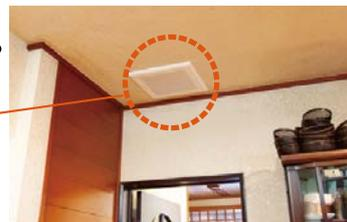
メインルームのCO<sub>2</sub>センサー搭載ダクト用換気扇(VD-20ZAGVX<sub>5</sub>-C)。こちらもDCブラシレスモーターを搭載している
