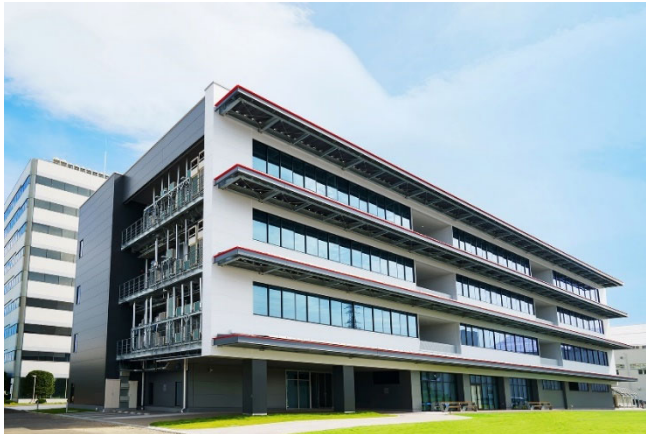
ZEB 関連技術実証棟「SUSTIE」
