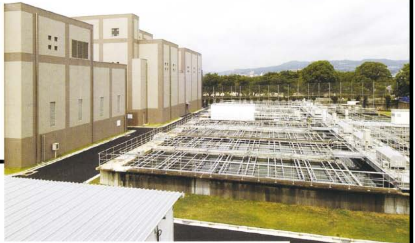
▲ 千僧浄水場全景
