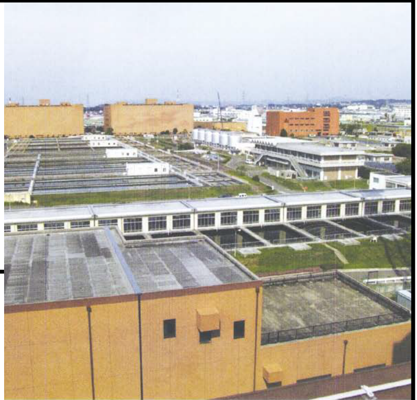
▲ 村野浄水場全景
