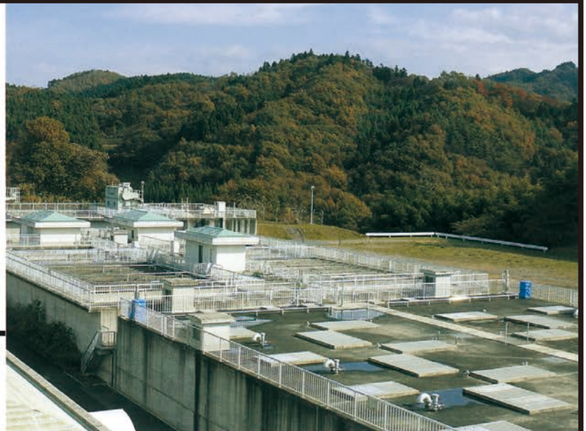
▲ 荒井浄水場全景
