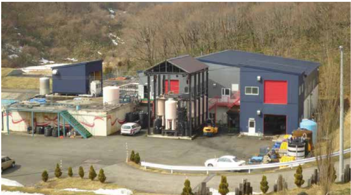
▲ 浸出水高度処理施設全景
