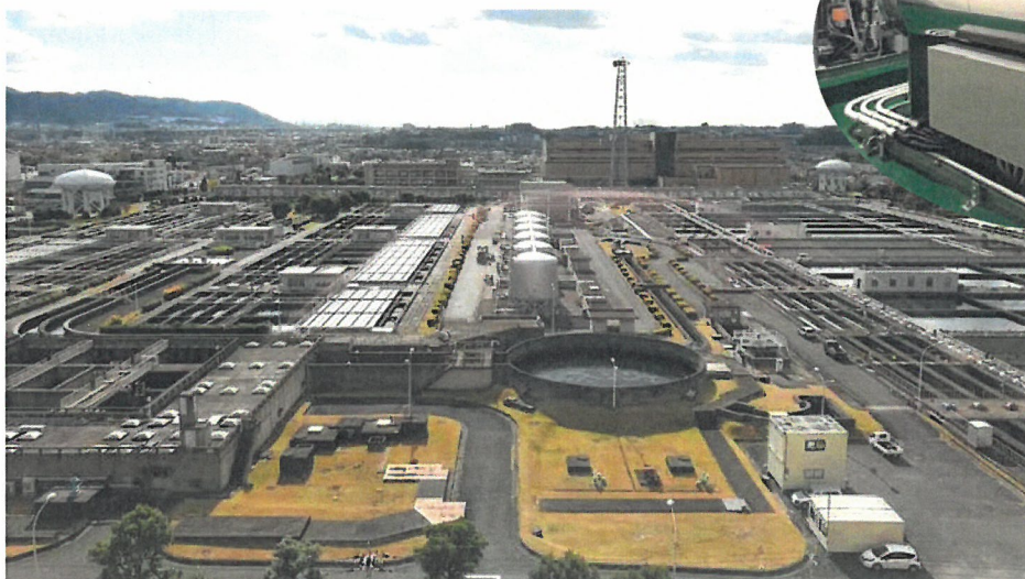
▲ 村野浄水場全景
