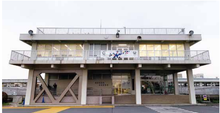
▲ 東村山浄水場
