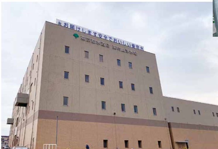
▲ オゾン棟全景
