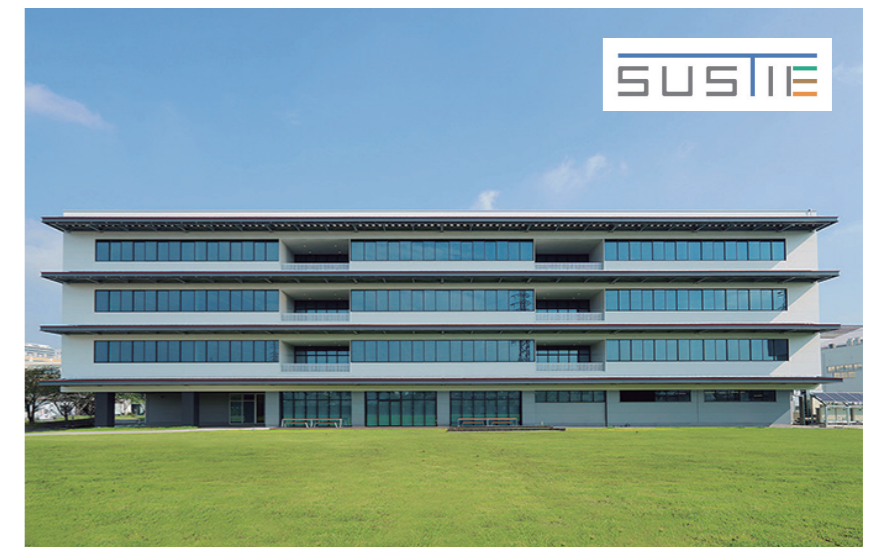
三菱電機・情報技術総合研究所(神奈川県鎌倉市)に竣工した「ZEB関連技術実証棟」(SUSTIE)。「CASBEE ウェルネスオフィス認証」でも最高の「Sランク」を取得した
