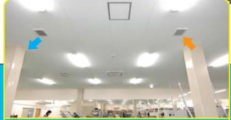
単独加湿ユニットは工場の面積に対して、ほぼ均等の間隔で設置されています。大型印刷機がある場所は、点検口が印刷機の真上にならないよう配慮しています。
