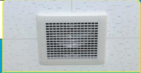
単独加湿ユニット吹出口の拡大写真。グリルは住宅用換気送風機の部材を使用しています。
