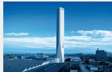
エレベーター試験塔[SOLAÉ(ソラエ)]
